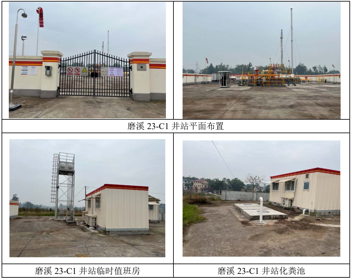
图 2.2-1 磨溪 23-C1 井站建设现状
